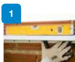
Instalación **Gecol perfil de coronación** en la coronación del sistema, fijado mecánicamente.
