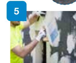
Refuerzo de esquinas internas y externas con bandas de refuerzo a medida de **Gecol Malla 160** colocado con mortero **Gecol Term**.
