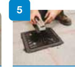
Una vez finalizada la instalación de la membrana en la cubierta, replantar el Soporte Soprasolar® Fix Evo TILT según plano proporcionado por Soprasolar®.
