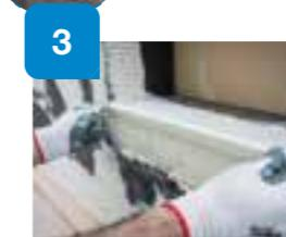
Refuerzo de alféitar mediante **Gecol perfil goterón** colocado con mortero **Gecol Term**.
