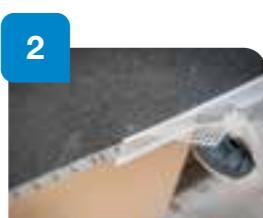
Instalación accesorio **Gecol suplemento de arranque** sobre el **Perfil de arranque**.
