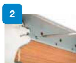
Instalación **Gecol perfil cierre lateral** en el cierre del sistema con edificios colindantes.
