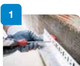
Fijación mecánica del **Gecol perfil de arranque** evitando empalmes a testa mediante **Gecol nivelador** y ajustando la plomada mediante **Gecol distanciador**.
