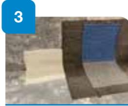
Refuerzo de la media caña con banda impermeable **Sopralastic 1K** armada con **Gecol Malla 70**.
