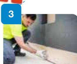
Instalación de aislamiento **SopraXPS CB** en la parte inferior del sistema inferior una distancia mínima de 5 mm del pavimento.
