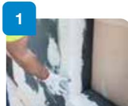
Refuerzo de aristas mediante **Gecol perfil esquina PVC** colocado con mortero **Gecol Term**.
