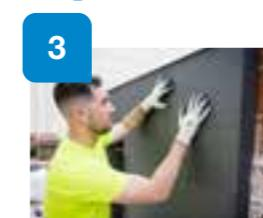
Instalación de los paneles aislantes hasta alcanzar la cota del perfil.
