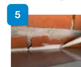
Sellado de la junta generada entre el perfil y el soporte con **Alsan® Flex 2911 CO**.
