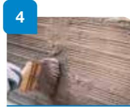
Impermeabilización del zócalo hasta una altura mínima de 20 cm con 2 manos de mortero **Sopralastic 1K** (3 kg/m<sup>2</sup>).
