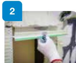
Refuerzo de dinteles mediante **Gecol perfil goterón** colocado con mortero **Gecol Term**.
