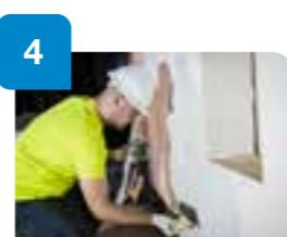
Refuerzo del zócalo con **Gecol malla antivandálica** colocada a testa y posterior refuerzo del sistema general.
