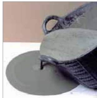
Vertido del producto sobre la superficie a nivelar.
