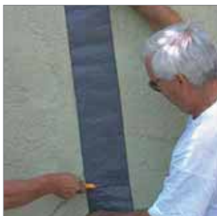
Medir la dimensión a cortar con la lámina.
