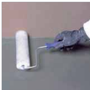
Si se quiere se puede eliminar el aire ocluido con un rodillo de más (no es estrictamente necesario).
