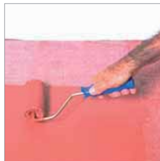
Aplicación de las siguientes capas.
