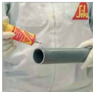
Aplicar el adhesivo en la zona de unión.
