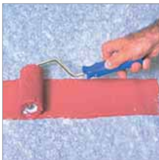
Imprimación del producto diluido (30% de agua).
