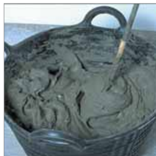
Homogeneización de la mezcla.
