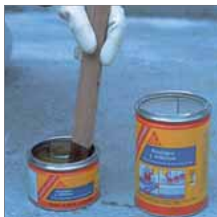
Homogeneización de los componentes.
