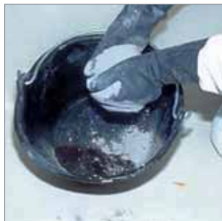
Vertido del cemento.
