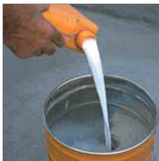
Vertido del componente A sobre el B.
