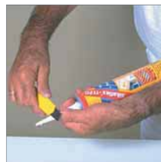
Corte de la boquilla en forma de bisel a 45°.
