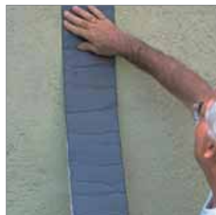
Colocar presionando fuertemente.
