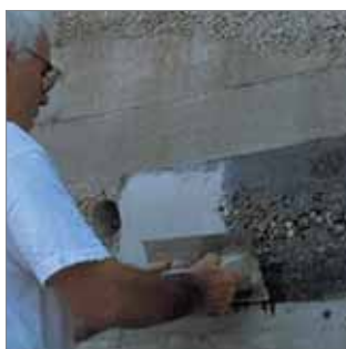
Aplicación del producto sobre imprimación fresca.
