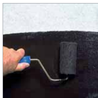
Imprimación con el producto diluido (10-20% de agua).
