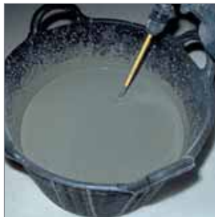
Homogeneización del mortero.
