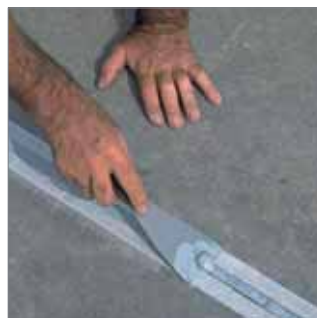
Retirada del exceso de producto.
