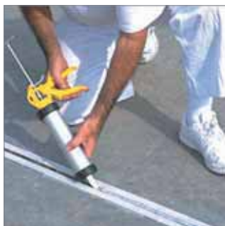
Aplicación de la masilla.
