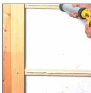
Aplicación del adhesivo.
