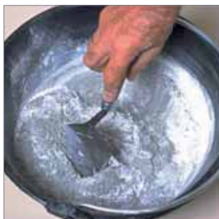
Mezcla del cemento y el aditivo.
