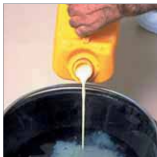
Mezcla del aditivo y el agua.
