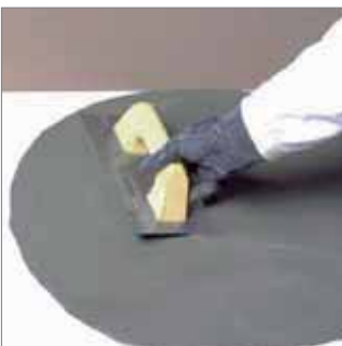
Ayudar al extendido del producto con una llana.
