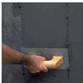
Aplicación de la primera mano con llana.
