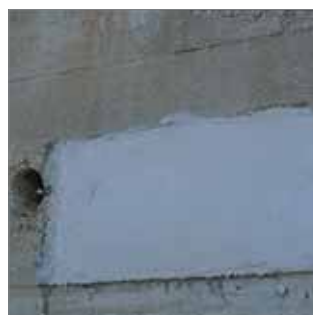
Terminación. Esperar 24 horas para su puesta en servicio.
