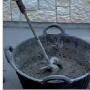
Homogeneización de la mezcla.
