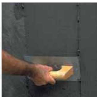
Aplicación de la primera mano con llana.
