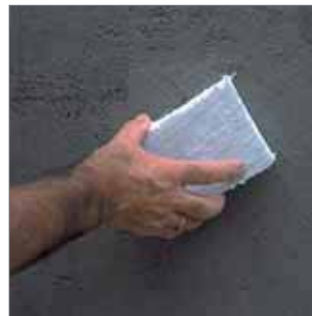
Terminación con un fratás de madera.
