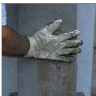
Taponar la vía de agua.
