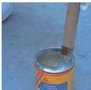
Homogeneización completa.
