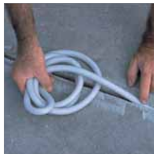
Colocación del Fondo de Junta Sika.
