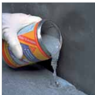
Vertido del mortero.
