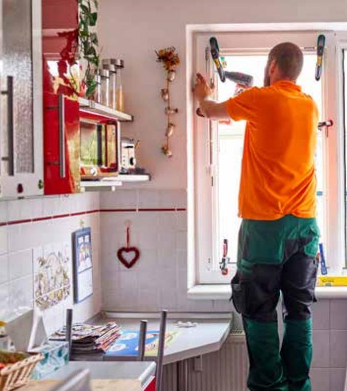
Unas 1.400 ventanas, 3 meses, 6 montadores: la renovación de 3 edificios plurifamiliares en Erfurt muestra cómo el montaje con marco de renovación por el interior de Finstral simplifica radicalmente la renovación de ventanas.
