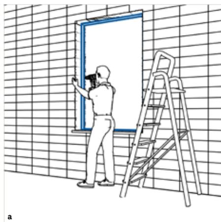
El premarco FIN-Fix se monta durante la fase de obra. Además de servir como elemento de preparación para la ventana, el premarco permite integrar equipamientos de la ventana como persianas, sistemas motorizados, ventilación, etc.
